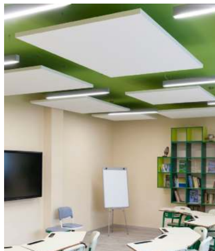
Хорошо Акустические панели в сочетании с окрашенным потолком
